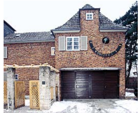
Dient heute als Büro- und Wohnhaus: das Landhaus Köttgen
